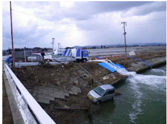
東北・津波浸水地での排水作業
